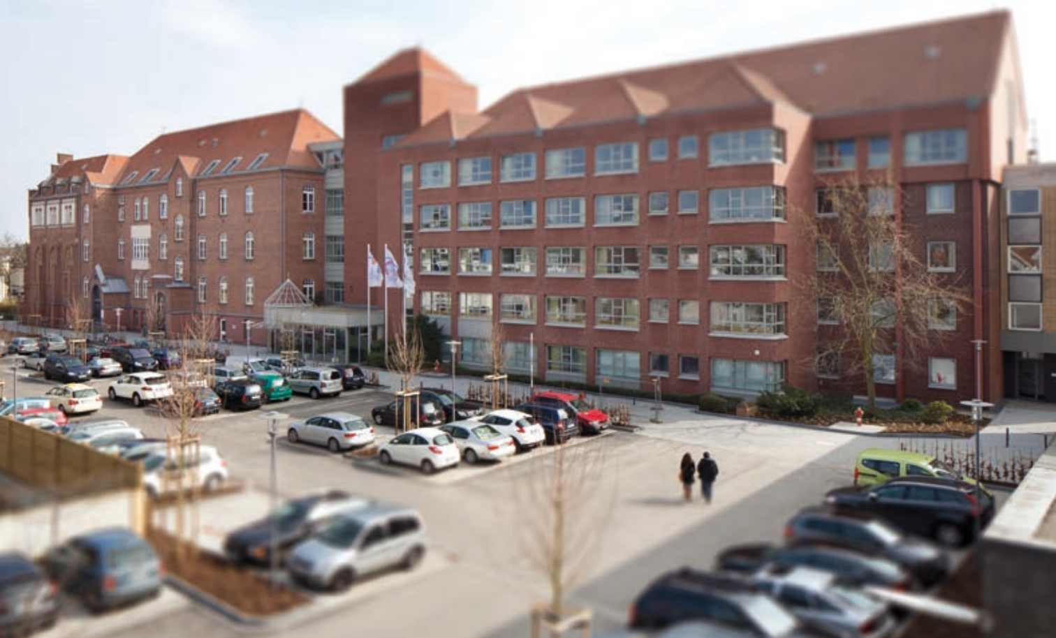
Durch die bisherigen Umbaumaßnahmen ist der Blick frei auf das St. Agatha Krankenhaus Köln-Niehl.
